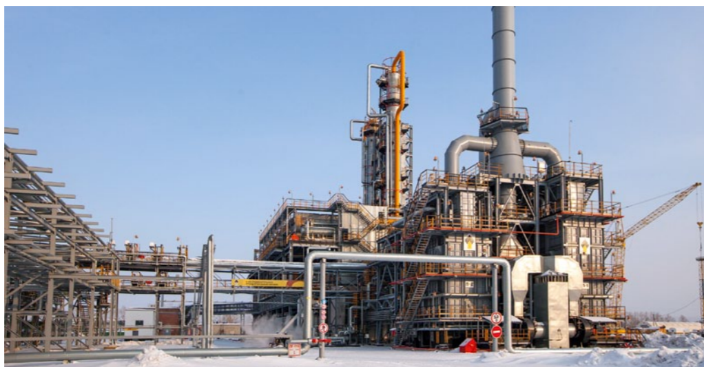
Масштабная модернизация Комсомольского НПЗ сравнима со строительством нового завода. Программа включает строительство новых установок гидрокрекинга, риформинга, коксования, а также 25 заводских объектов.
