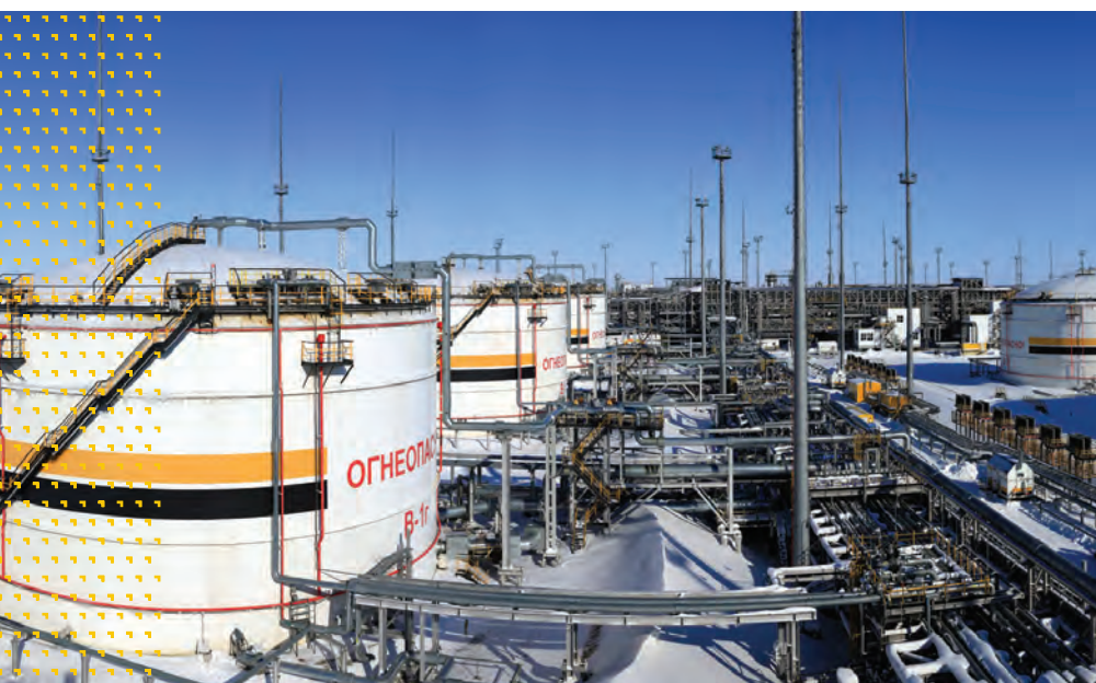
НК «Роснефть» в сжатые сроки завершила реализацию проекта по созданию уникального международного энергетического хаба на базе Ванкорского месторождения.
